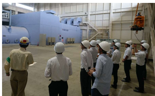
写真2 タービン建屋見学(新港火力発電所)
